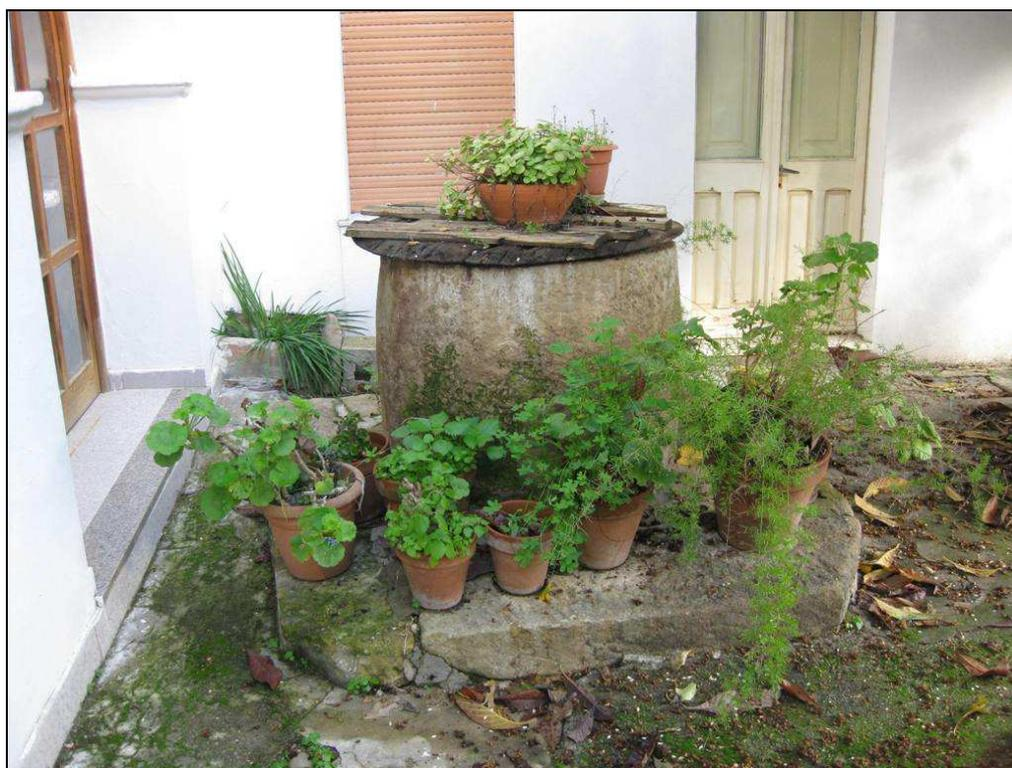
**Foto 6** Fontana in area cortilizia con parapetto esterno realizzato con un unico blocco di arenaria di forma circolare.
