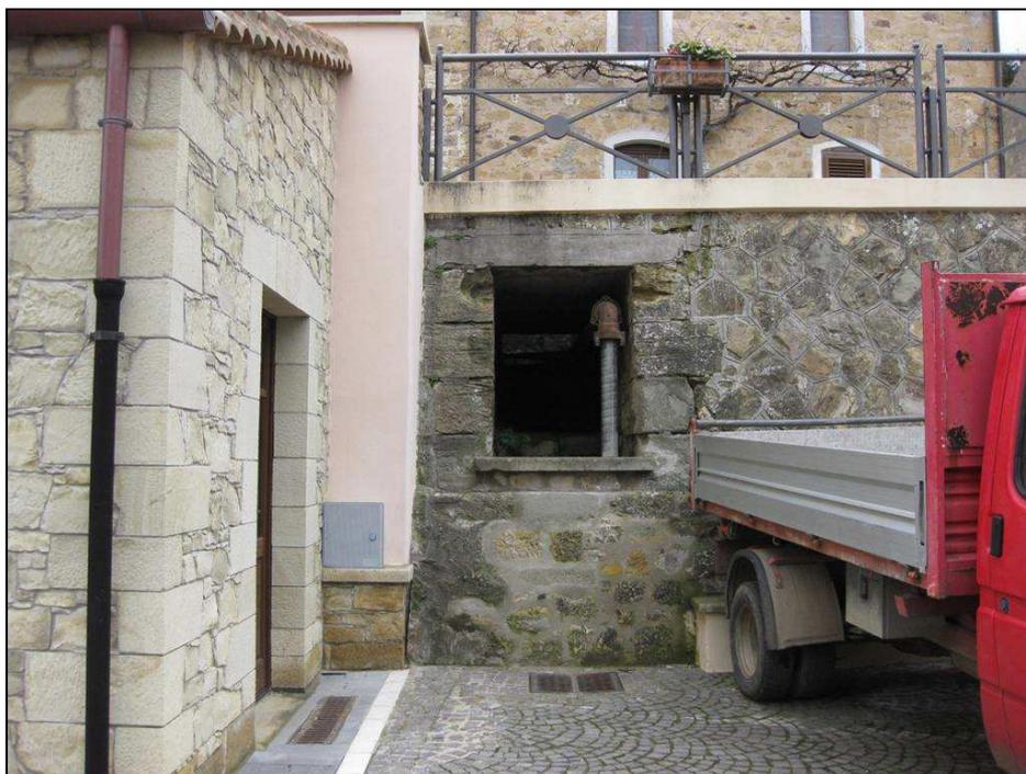
**Foto 14** Scatolare che attraversa la Via Vittorio Emanuele III che consente il deflusso delle acque proveniente da Sa Serra e su Casteddu.
