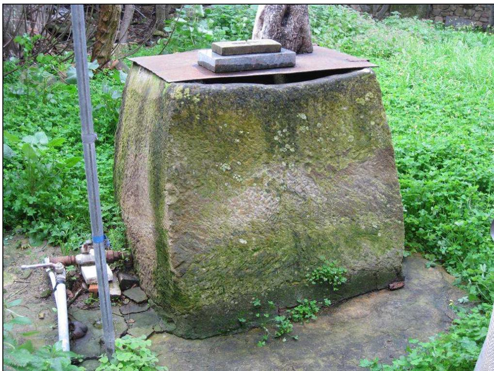
**Foto 7** Fontana in area cortilizia con parapetto esterno realizzato con un unico blocco di arenaria di forma quadrata.
