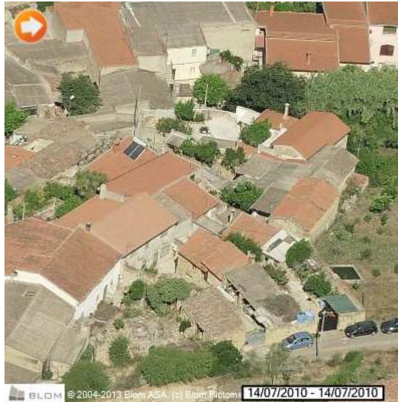
Viste oblique Est / Nord / Sud / Ovest del Lotto 3
