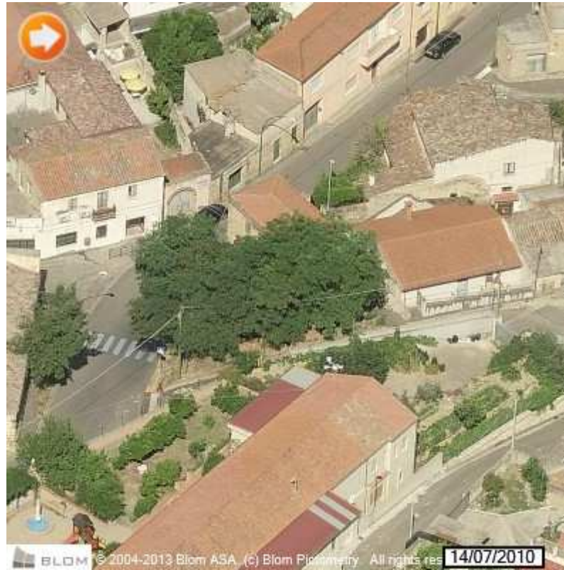
Viste oblique Est / Nord / Sud / Ovest del Lotto 10
