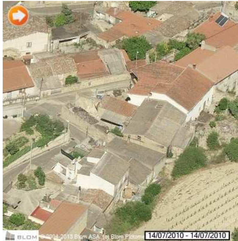
Viste oblique Est / Nord / Sud / Ovest del Lotto 1
