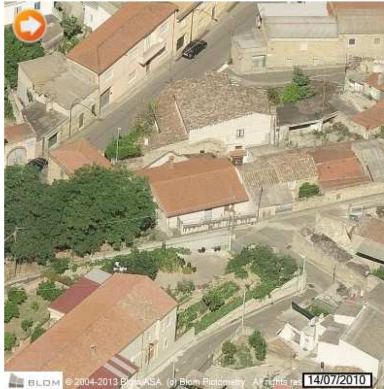
Viste oblique Est / Nord / Sud / Ovest del Lotto 9
