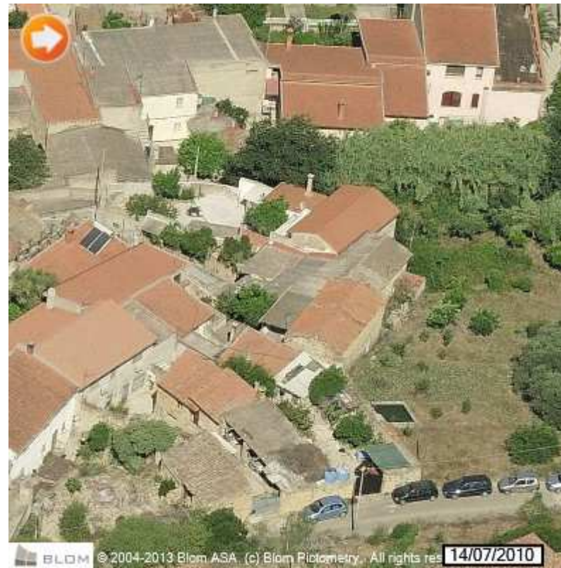
Viste oblique Est / Nord / Sud / Ovest del Lotto 12
