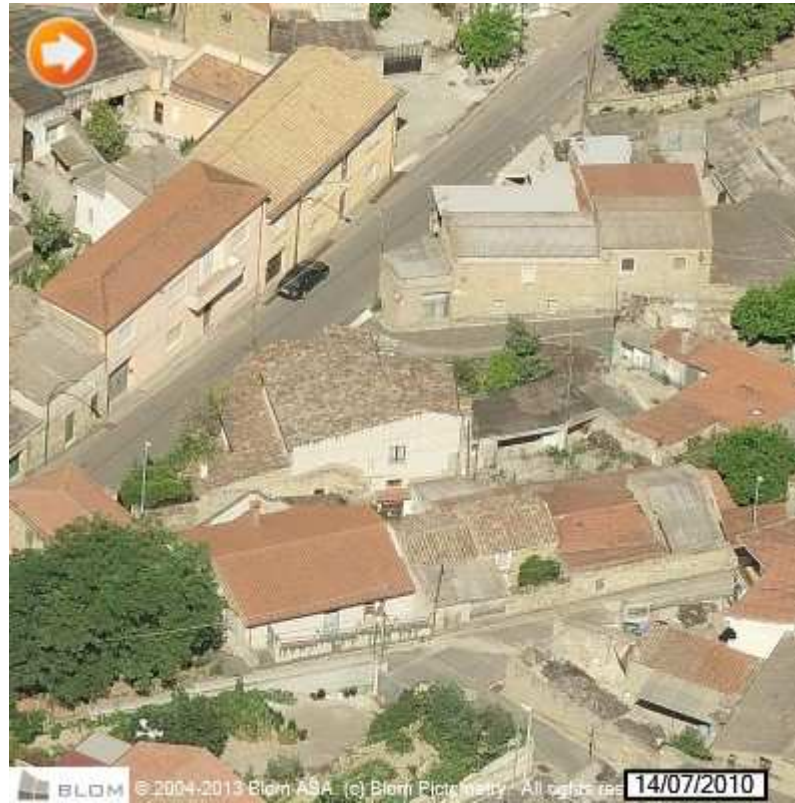
Viste oblique Est / Nord / Sud / Ovest del Lotto 7
