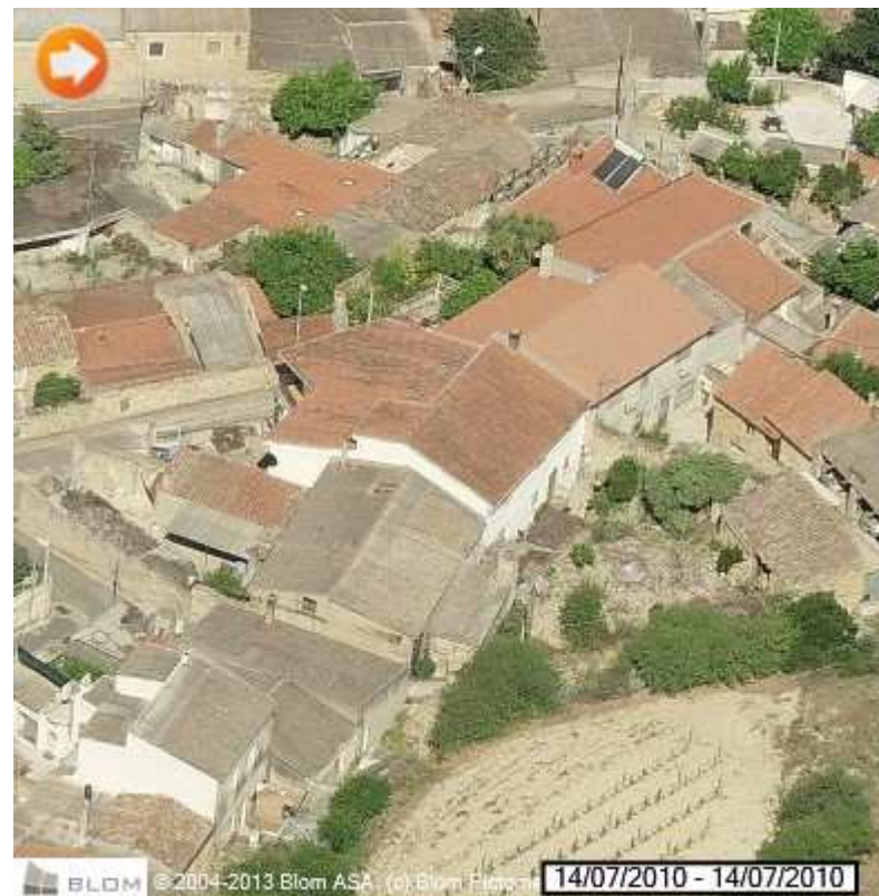
Viste oblique Est / Nord / Sud / Ovest del Lotto 14
