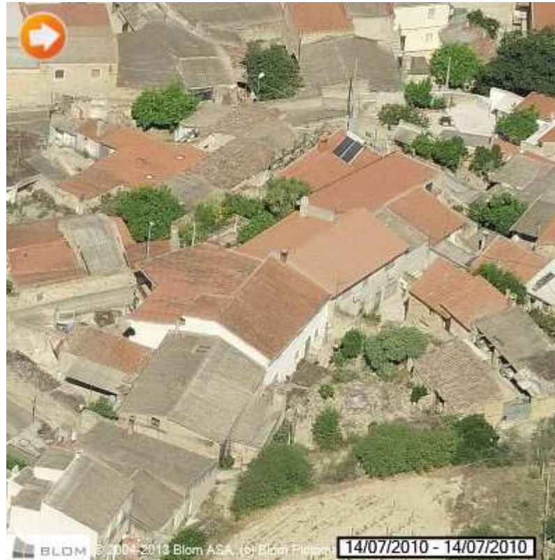
Viste oblique Est / Nord / Sud / Ovest del Lotto 2
