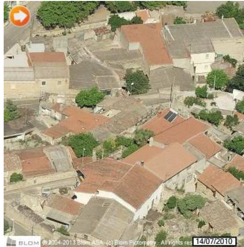
Viste oblique Est / Nord / Sud / Ovest del Lotto 4
