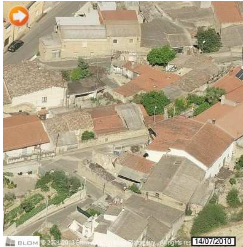
Viste oblique Est / Nord / Sud / Ovest del Lotto 6
