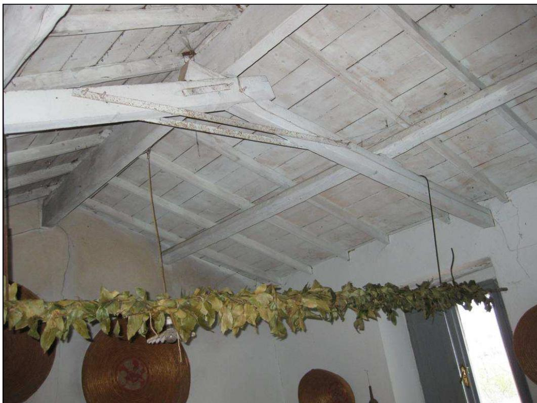
**Foto 17** Carpenteria lignea a triangolo rigido introdotta per contrastare le spinte sui setti derivanti dai puntoni di copertura.
