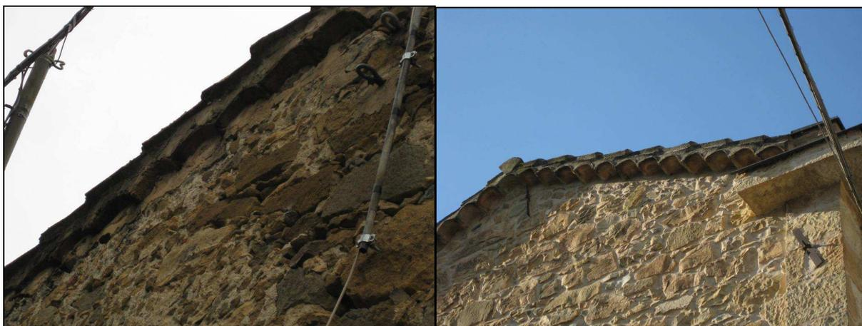
**Foto 27** Coronamento di testata con doppia fila di tegole convesse sovrapposte, disposte su una fila di tegole ad esse ortogonali aggettanti rispetto alla superficie del muro.
