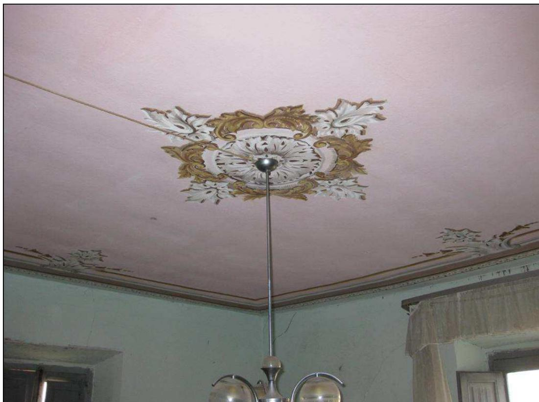
**Foto 8** Controsoffittatura a “Bovida” intonacato con modanature e disegni
