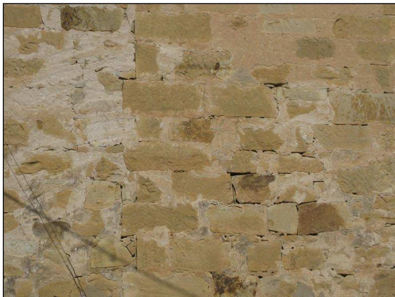
**Foto 8** Muratura con conci in arenaria sbazzati e squadrati, apparecchiati a secco con allettamento in malta di calce, secondo corsi orizzontali con parziale ricopertura dei blocchi con malta di calce.
