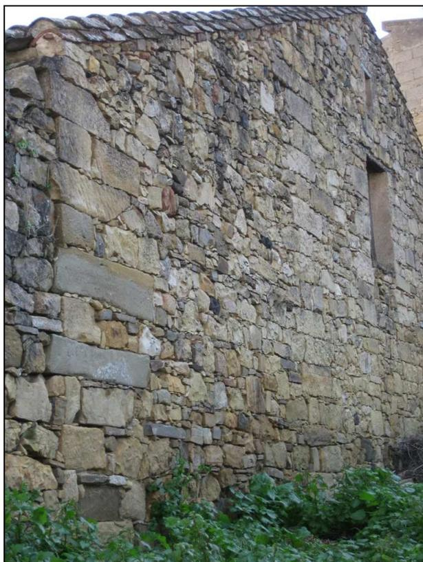
**Foto 6** Muratura con trovanti di arenaria, di piccole e grandi dimensioni, apparecchiati a secco, con allettamento in terra, rinzeppatura, secondo corsi di spianamento sub-orizzontali e cantonali di grosse dimensioni.
