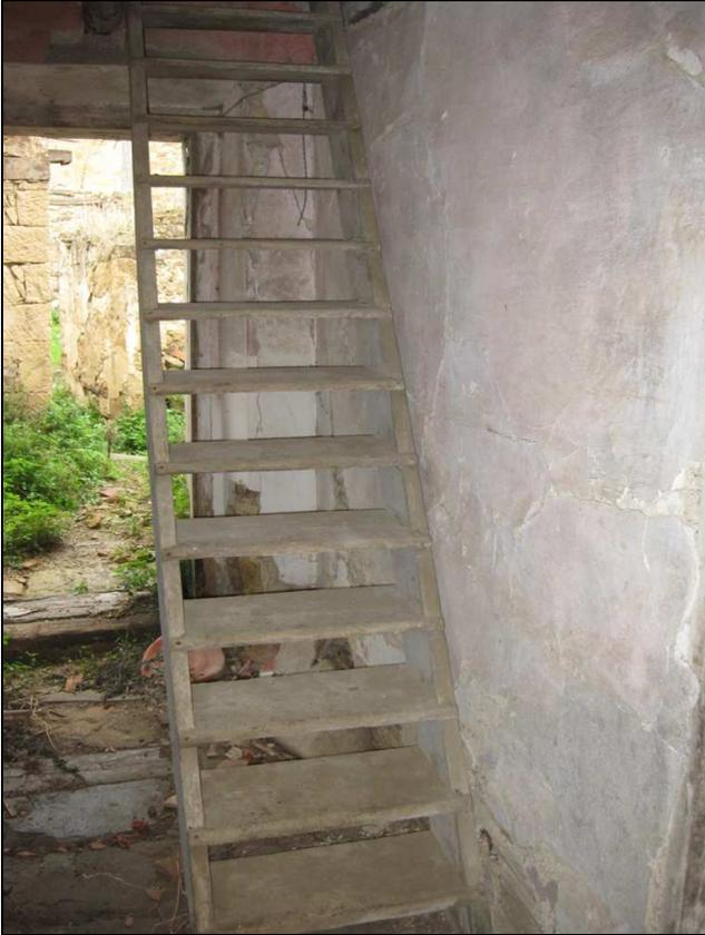
**Foto 20** Scale lignee realizzate con gradini vincolati e sostenuti da travi inclinate a sezione rettangolare.
