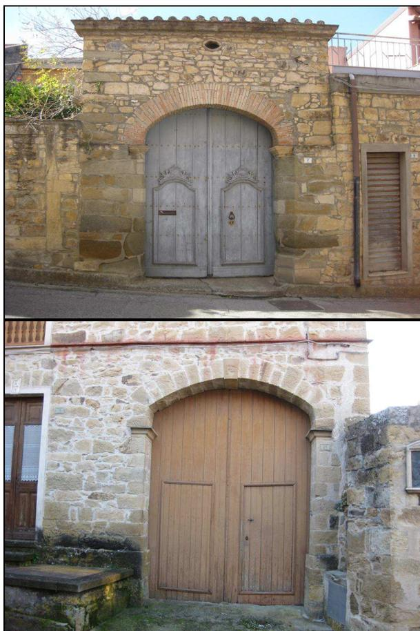
**Foto 27** Portali con arco a sesto ribassato in mattoni cotti a due teste, in conci lapidei di arenaria e stipiti in conci lapidei di arenaria e portone a due ante in doghe di legno.
