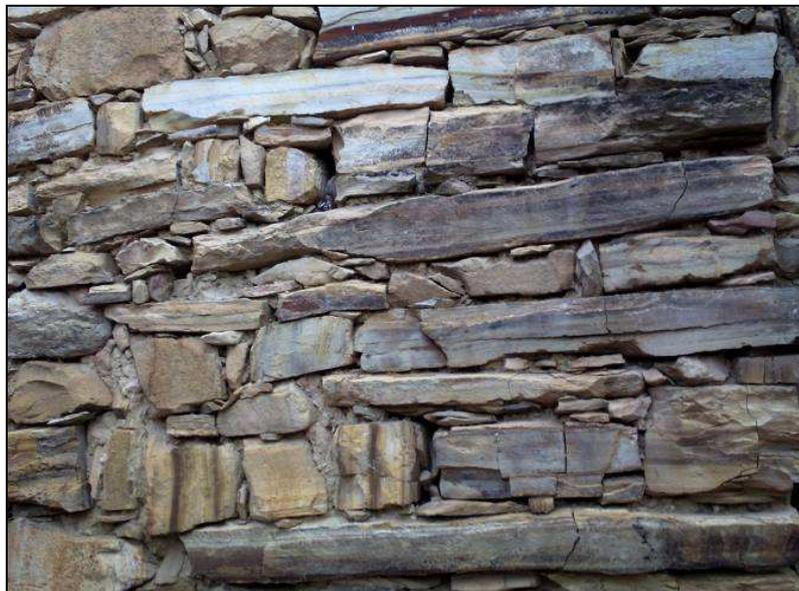
**Foto 4** Muratura ad opera incerta con trovanti di scisto laminari e arenaria, di piccole e grandi dimensioni, apparecchiati con allettamento in terra e rinzeppatura a scaglie.
