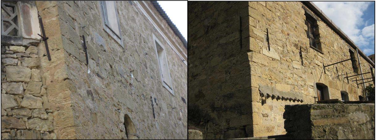
**Foto 11** Solaio incatenato con capochiavi metallici.
