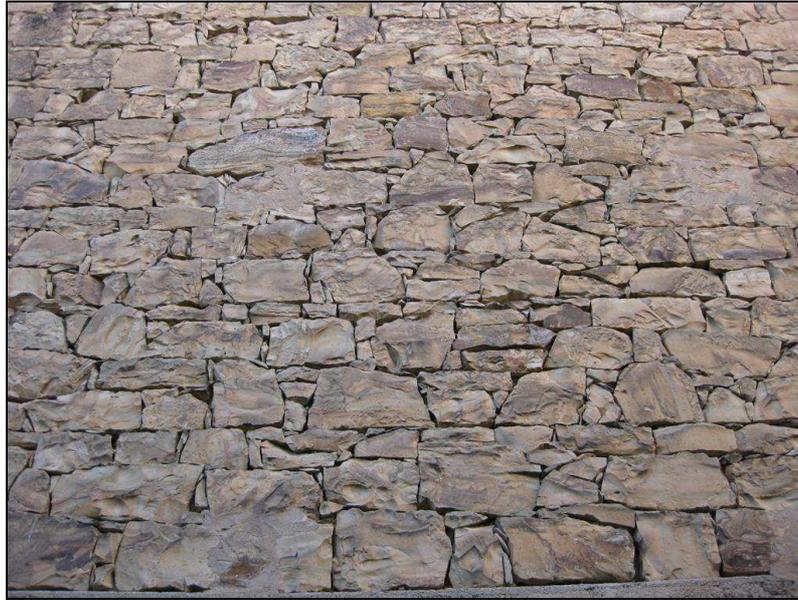
**Foto 7** Muratura con conci in arenaria sbazzati e squadrati, apparecchiati a secco con allettamento in terra, secondo corsi orizzontali
