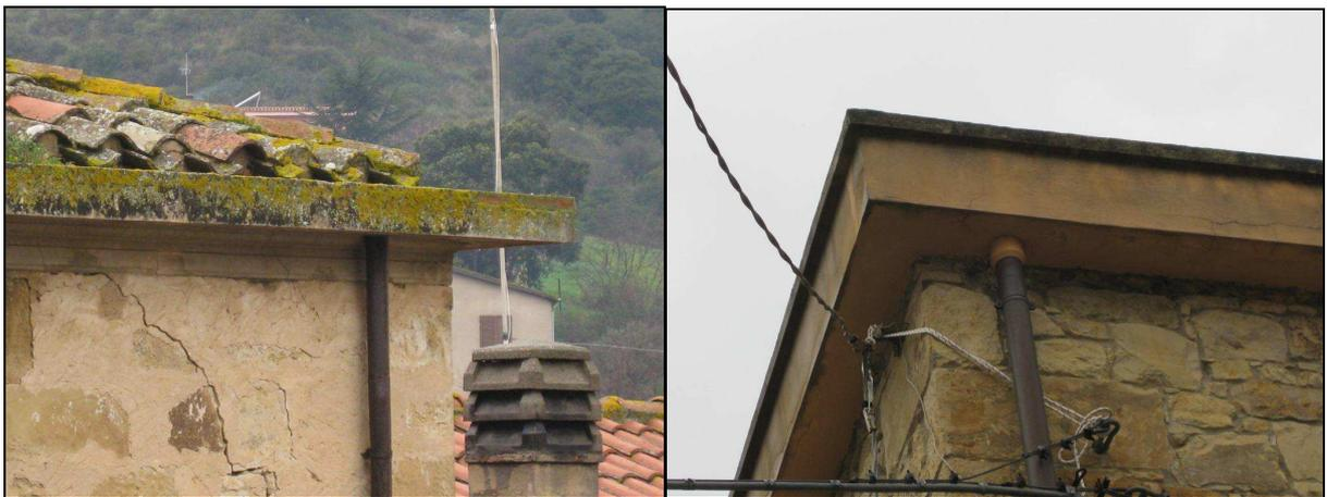
**Foto 25** Cornice aggettante realizzata in laterizi o conci lapidei intonacata, priva di muretto d'attico. Smaltimento delle acque attraverso canale di raccolta, discendente laterale.
