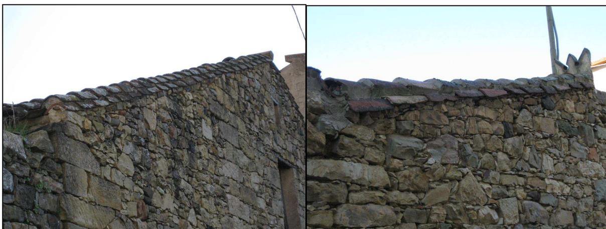
**Foto 26** Coronamento di testata con doppia fila di tegole convesse, sovrapposte e disposte a filo muro.
