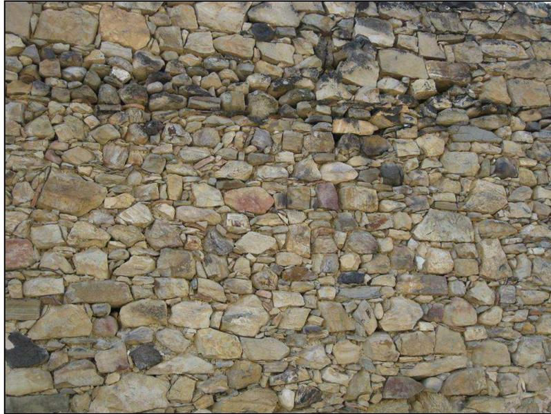
**Foto 1** Muratura in trovanti di arenaria di piccole dimensioni, allettati in terra e rinzeppati con elementi di pezzatura minuta, apparecchiati secondo corsi di spianamento occasionali.
