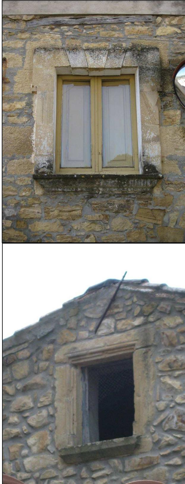
**Foto 17** Finestre con stipiti e orizzontamenti in conci lapidei squadrati non ammorsati alla muratura, con decorazioni in rilievo.
