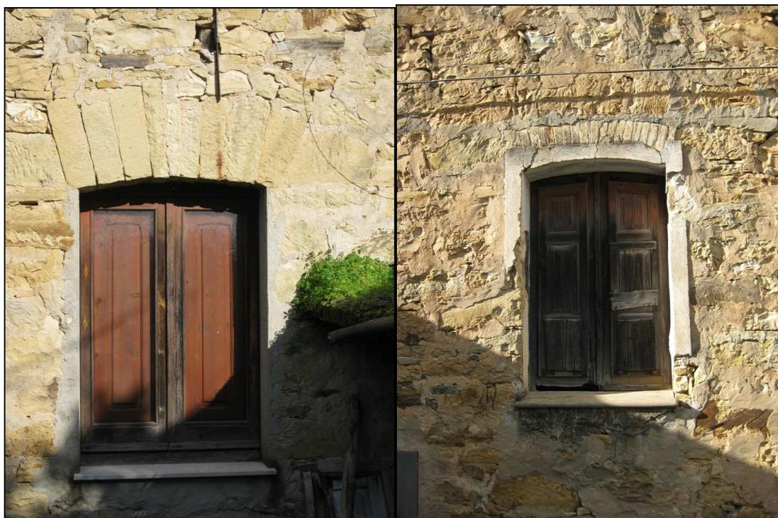
**Foto 15** Finestre con arco ribassato in conci lapidei sbizzati; in mattoni cotti e stipiti in conci lapidei.
