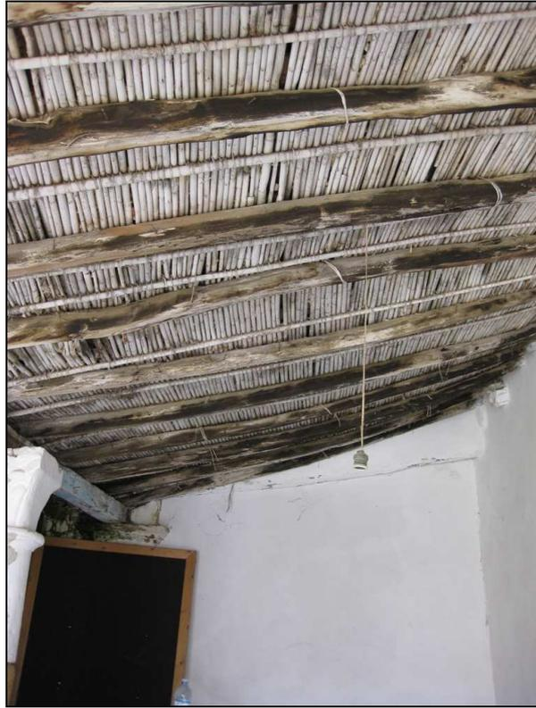
**Foto 186** Copertura di un loggiato a falda unica a semplice orditura con travicelli a sostegno di incannucciato
