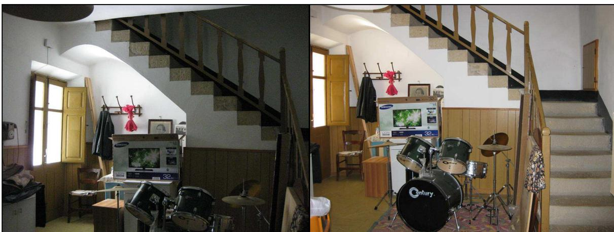
**Foto 21** Scala a L con struttura ad arco rampante realizzata con blocchi di arenaria. Il podio dei primi sette gradini con relativo pianerottolo funge da struttura d'imposta per l'arco rampante del quale può contrastare la spinta orizzontale. In sommità l'arco rampante è direttamente impostato sul muro perimetrale.
