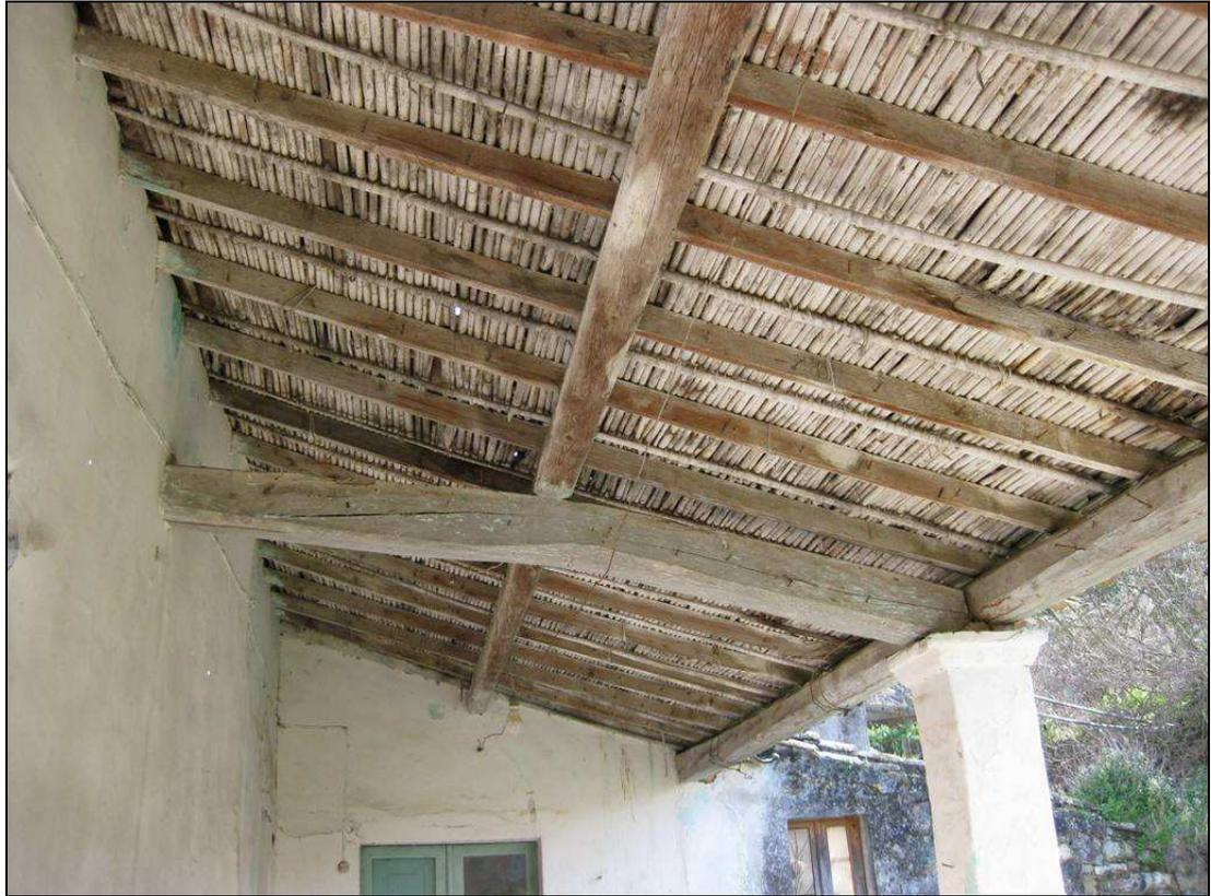
**Foto 70** Copertura di un loggiato a falda unica a orditura tripla con arcarecci e travicelli a sostegno di incannucciato
