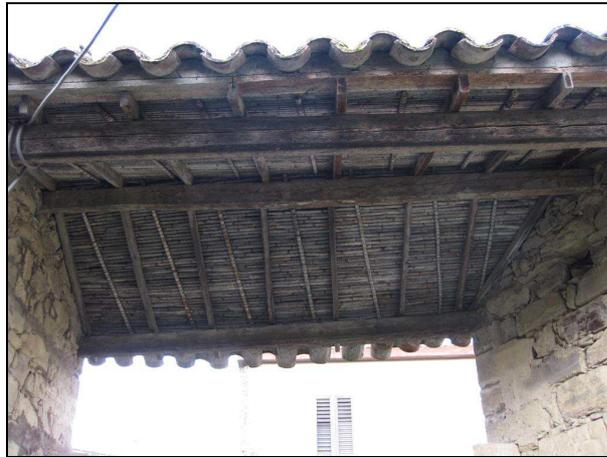
**Foto 29** Coperture di portali rispettivamente a una e a due falde con orditura lignea doppia e rispettivamente con impalcato in tavole e incannucciato e manti di copertura in coppi.
