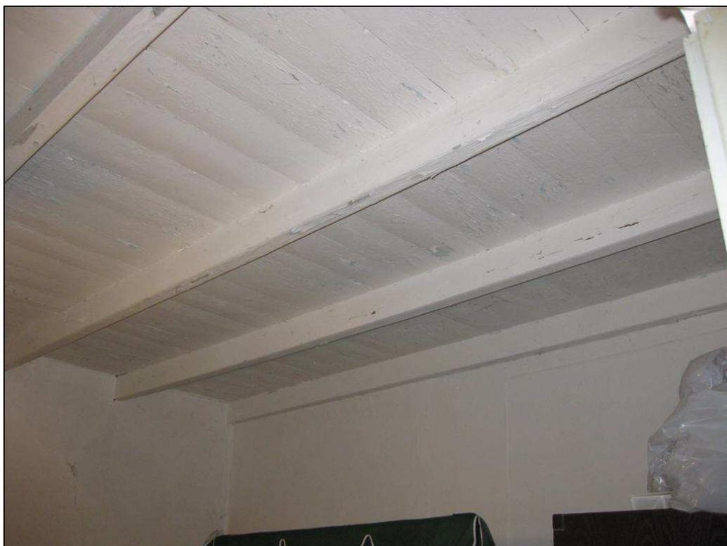
**Foto 29** Solaio a orditura semplice con travi a sezione rettangolare con le dimensioni in rapporto 1 a 2 e tavolato sovrastante
