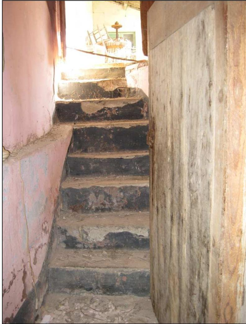
**Foto 22** Scala rettilinea in muratura inserita tra due cantonali, da notare l'irregolarità delle alzate.
