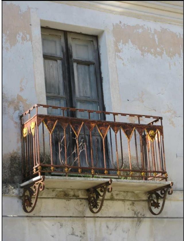
**Foto 38** Esempio di portafinestra e balcone con parapetto in ferro battuto. L'impalcato è realizzato con una lastra di marmo sorretta da mensole in ferro battuto.
