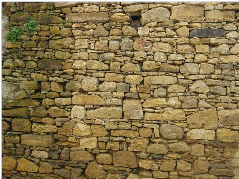
**Foto 6** Muratura con trovanti di arenaria, di piccole e grandi dimensioni, apparecchiati a secco, con allettamento in terra, rinzeppatura, secondo corsi di spianamento sub-orizzontali.
