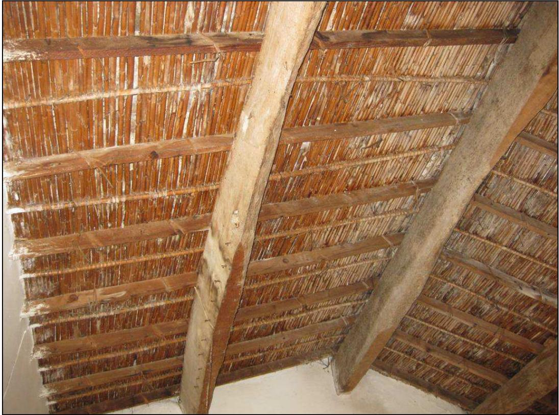
**Foto 19** Copertura a doppia falda e doppia orditura con arcarecci e travicelli a sostegno di incannucciato
