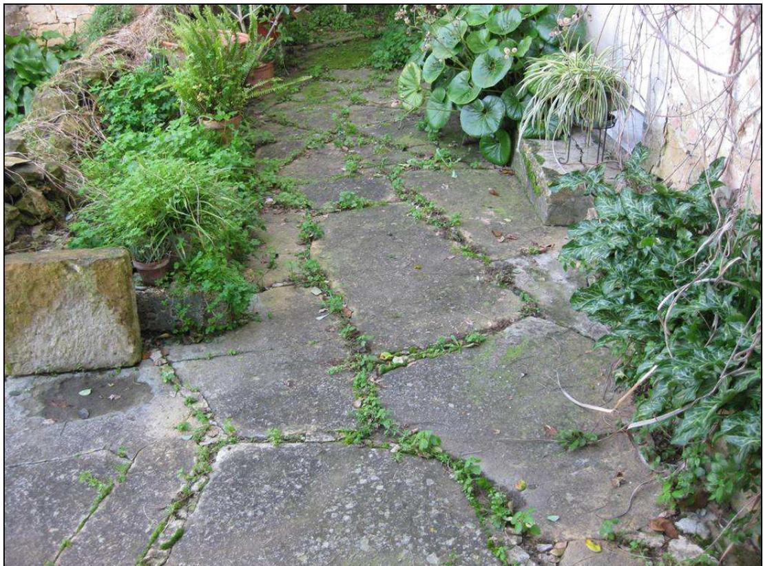
**Foto 24** Pavimentazione corte realizzata con lastre di forma irregolare di arenaria.
